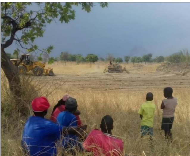
Die Unterstützung des Vereins hat es ermöglicht, Bagger zu mieten, die für den Aushub des Deiches notwendig sind.
